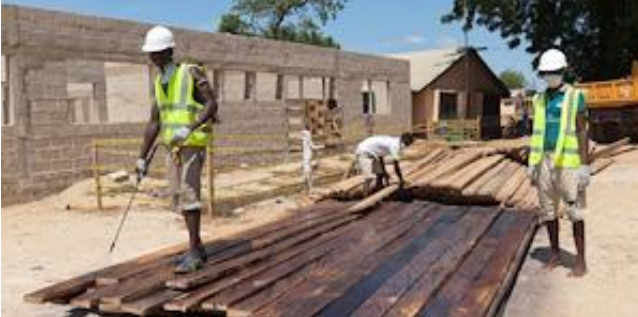
Impregneren van het hout
